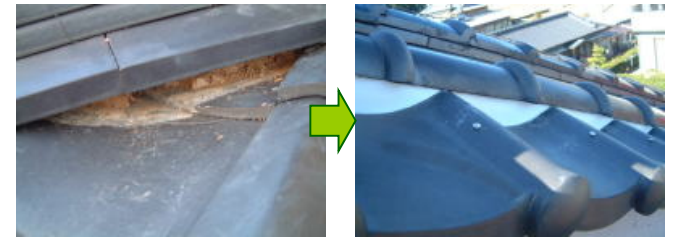
漆喰の塗り直し
