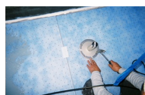
ステンレス脱気筒取付け
