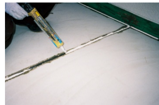
目地部にシーリング`充填
