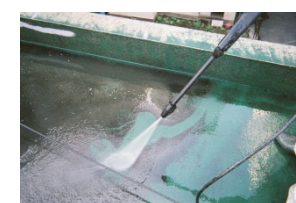
バイオ高水圧洗浄
