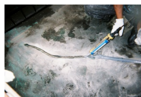
スラブシーリング
