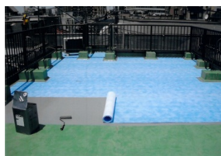
絶縁シート敷き
